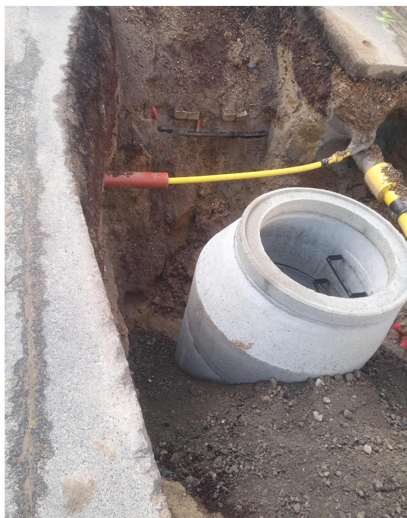
Kanalumbau in der Marktstraße in Oberwalluf 2024 © Gemeinde Walluf
