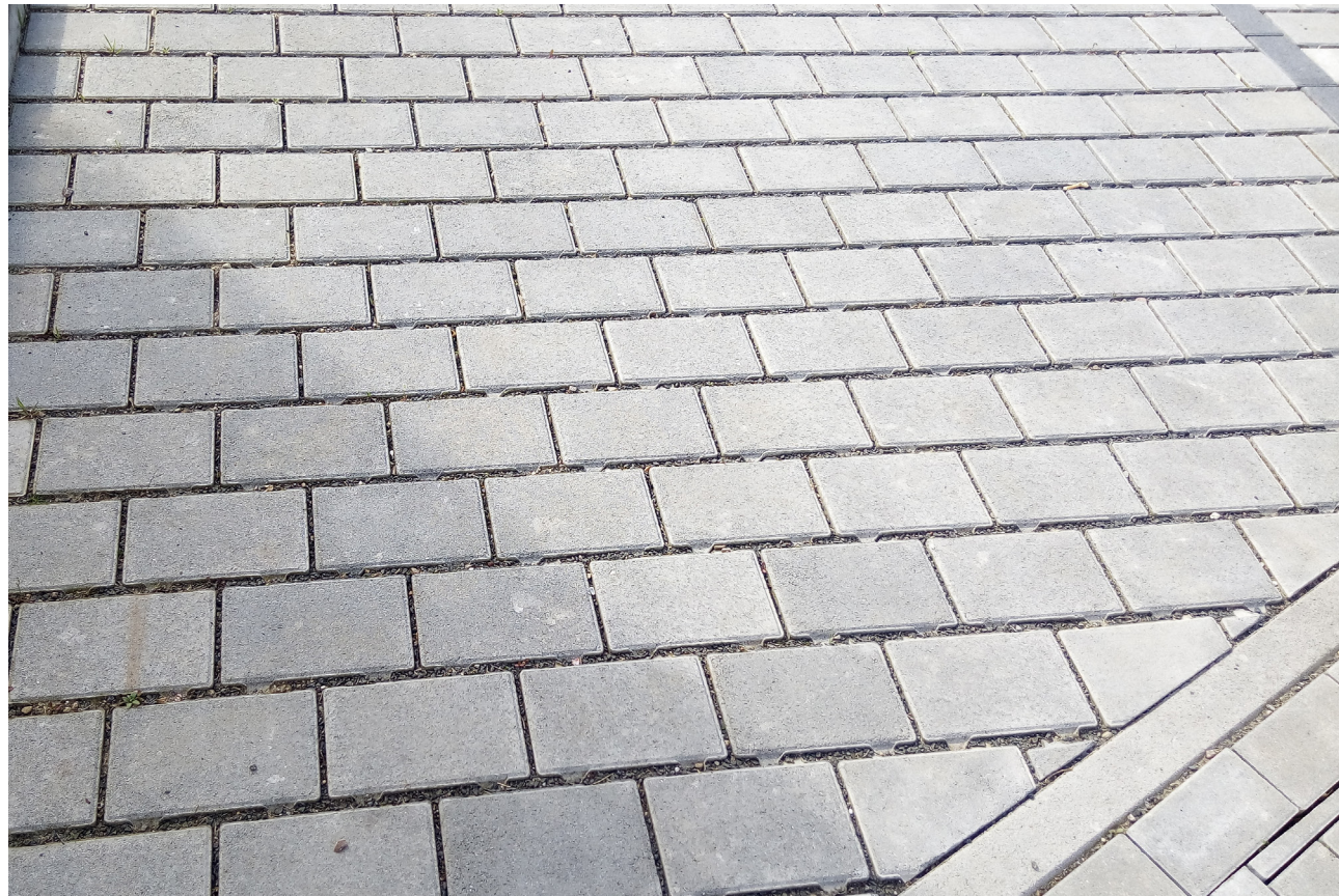
Abb. 2: Ökopflaster mit breiten Fugen auf dem Parkplatz am Badehaus verbessert die Versickerungsfähigkeit der Fläche. © Stadt Oestrich-Winkel
