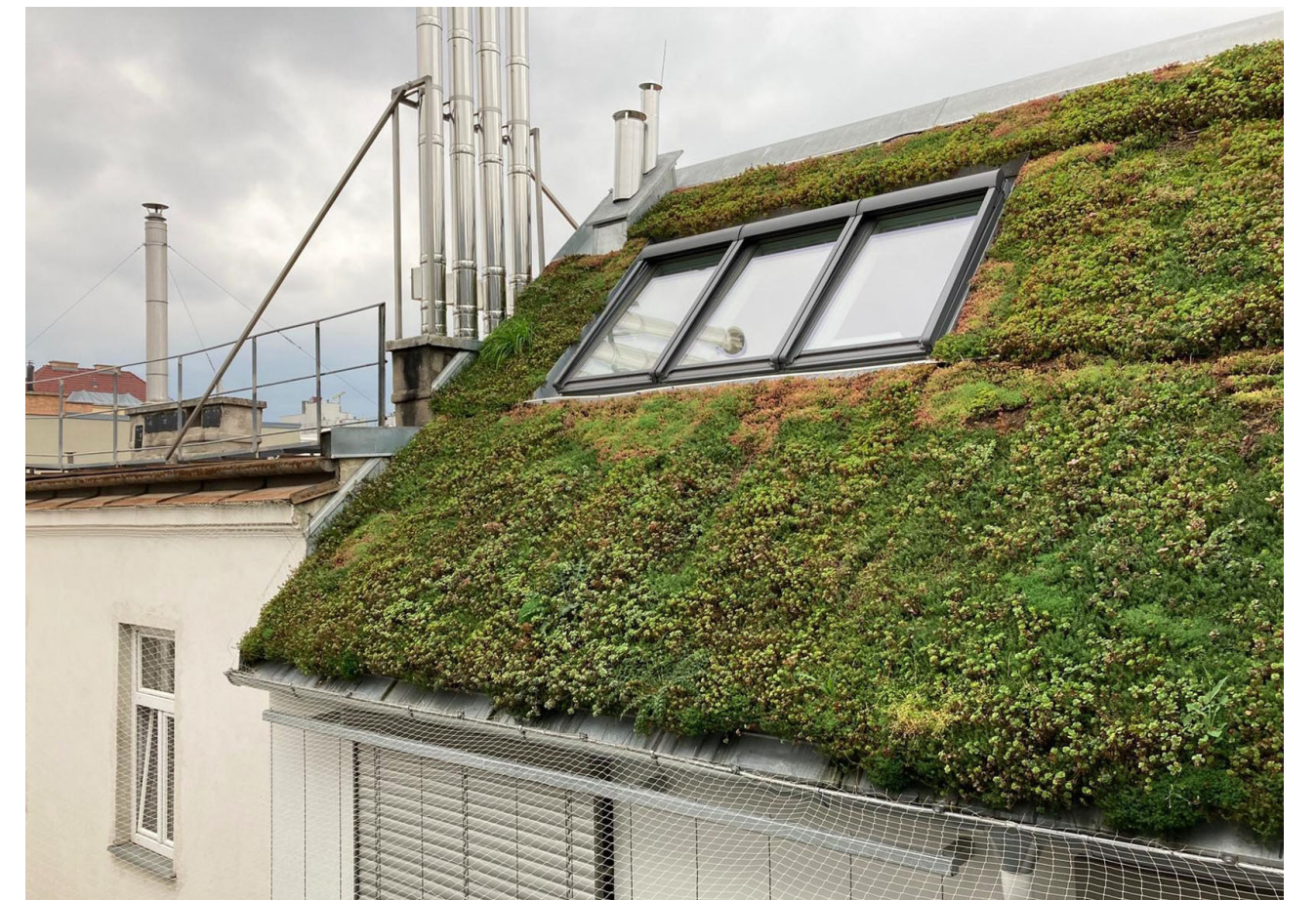
Dachbegrünung eines Schrägdaches als ein Beispiel für eine Maßnahme zur Klimaanpassung, die durch die Förderrichtlinie zur Stadtbegrünung bezuschusst werden kann. © GRUEN
