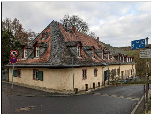
Abbildung 8: Gebäude mit Walmdach in Ziegeleindeckung mit Schiefereinfassung
