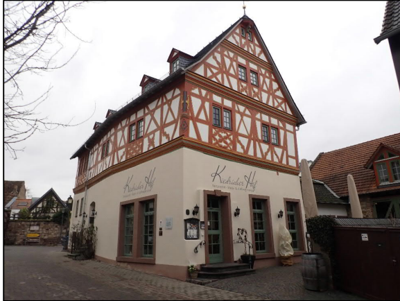
Abbildung 6: Fachwerkbau des Kiedricher Hofes in der Oberstraße
