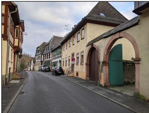
Abbildung 4: Geschlossene Häuserreihe mit giebel- und traufständigen Gebäuden mit Tordurchfahrten entlang der Suttonstraße
