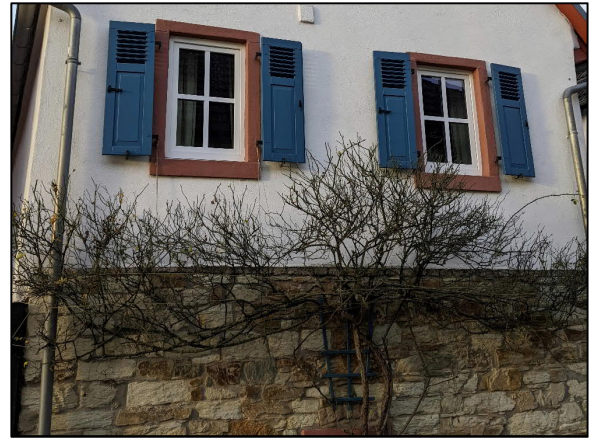
Abbildung 21: Sanierte Fassade in der Oberstraße
