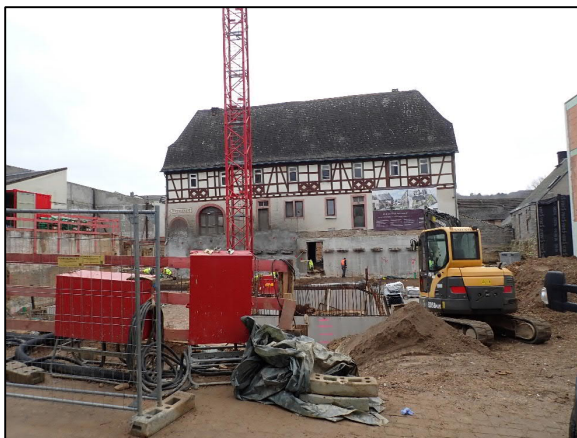
Abbildung 36: Innenentwicklungsprojekt „Wohnen im Gutshof“ in der Kammstraße, Stand Februar 2023
