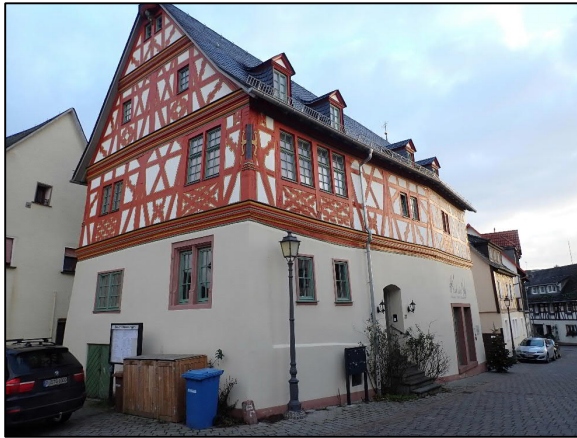
Abbildung 20: Vorbildlich saniertes Fachwerkgebäude in der Oberstraße
