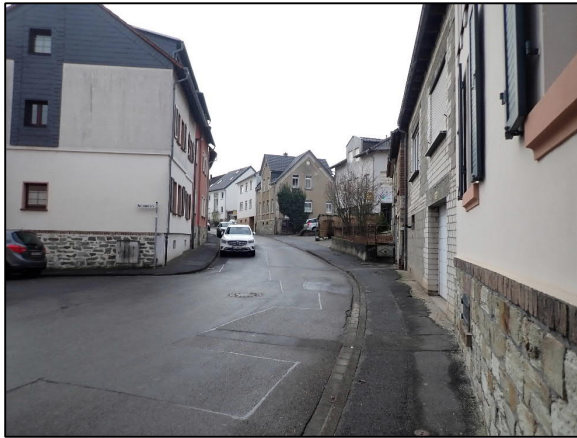
Abbildung 17: Bebauung mit geschlossenen Häuserreihen und teilweise erhaltenswerter Bausubstanz in der Aulgasse
