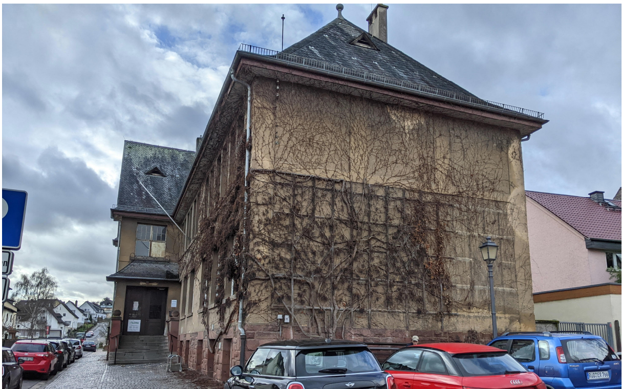
Abbildung 44: Alte Schule Kiedrich Rückseite
