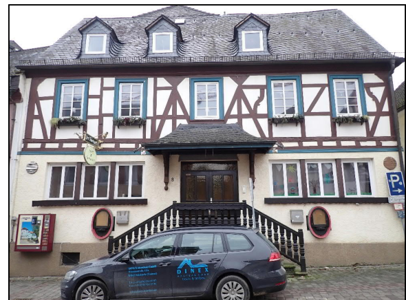
Abbildung 9: Gebäude mit Satteldach in Schiefereindeckung und Gauben in der Oberstraße
