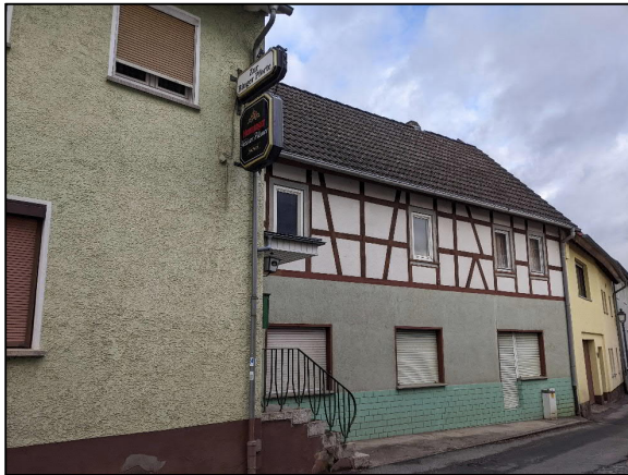
Abbildung 26: Unsaniertes Fachwerkgebäude mit ortstypischen Baumaterialien
