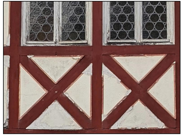
Abbildung 25: Verwitterte Fachwerkfassade
