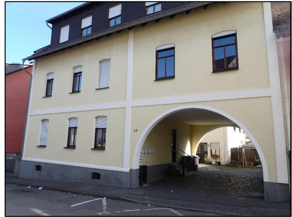
Abbildung 18: Gebäude mit Tordurchfahrt in der Aulgasse
