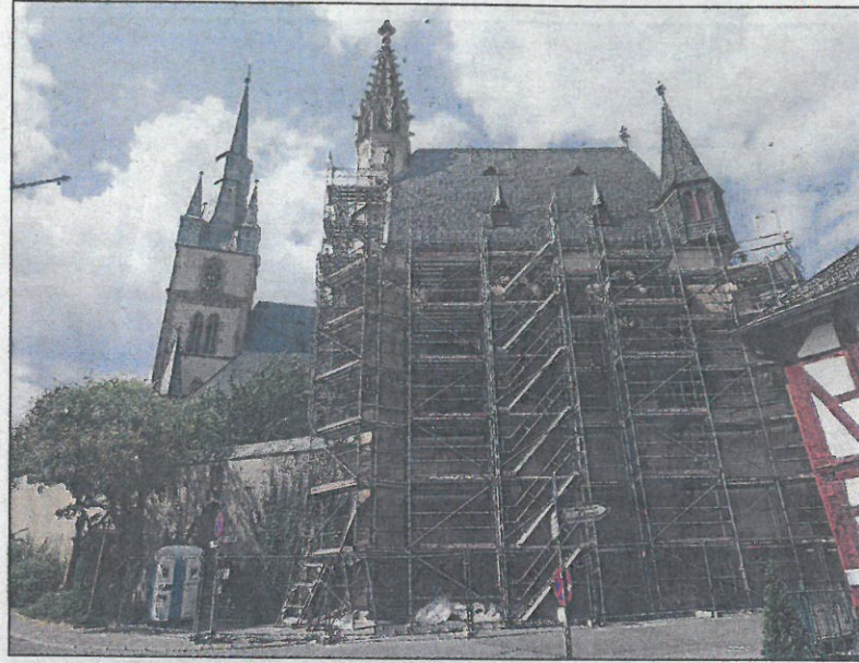
Um die Fassade restaurieren zu können, ist die Michaelskapelle seit einigen Tagen eingerüstet.
